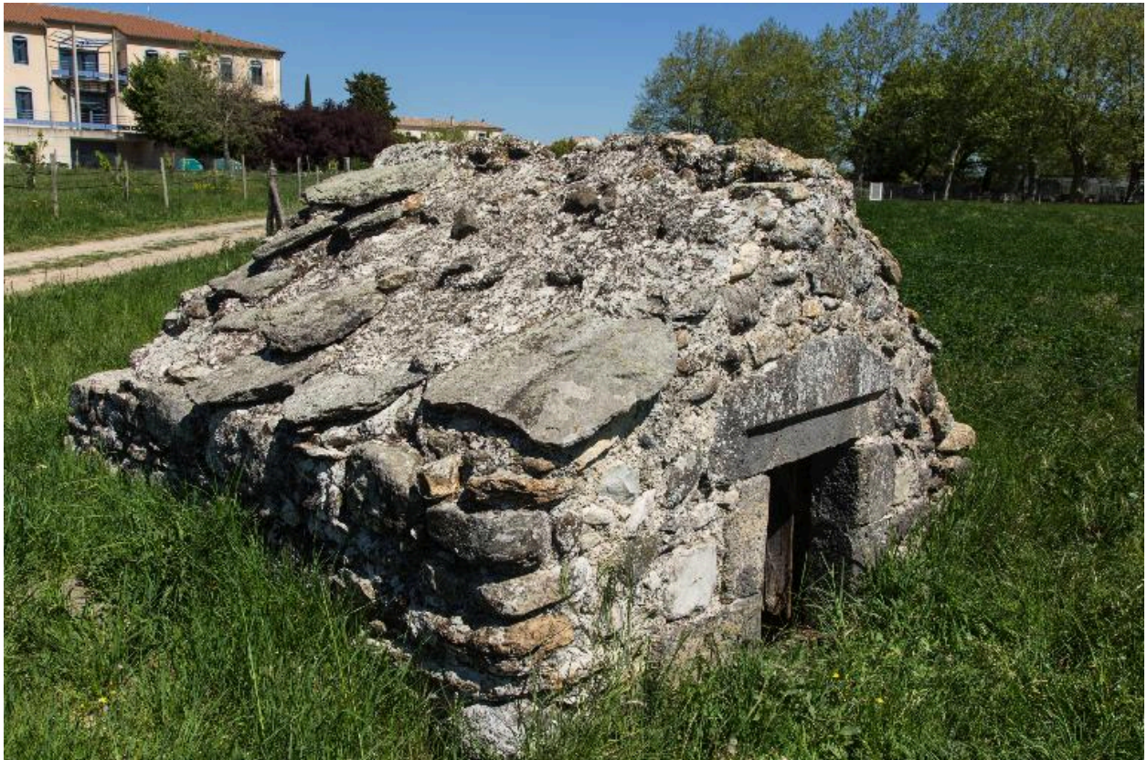
Mère des fontaines : toiture
