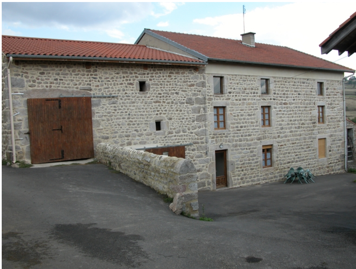
Vue générale depuis le sud.
