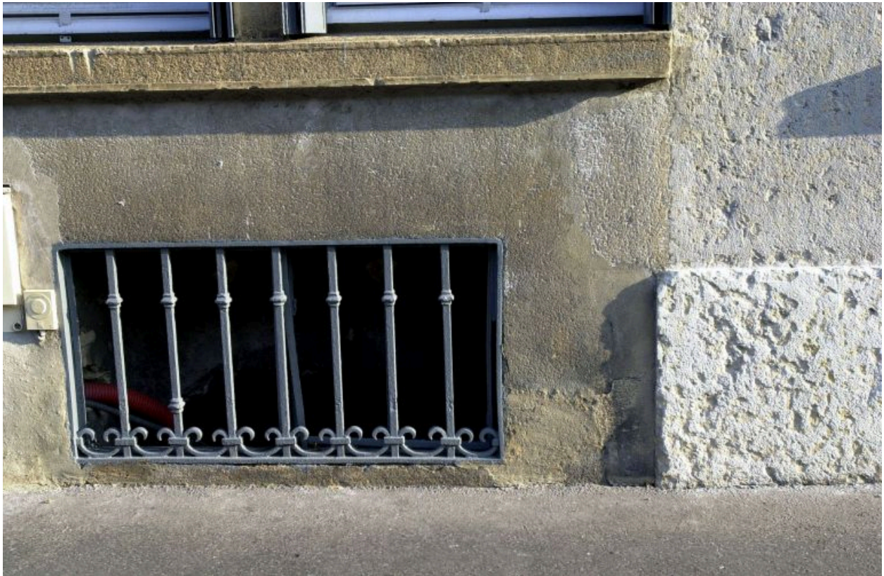
Détail d'un sopirail rue Dugas-Montbel
