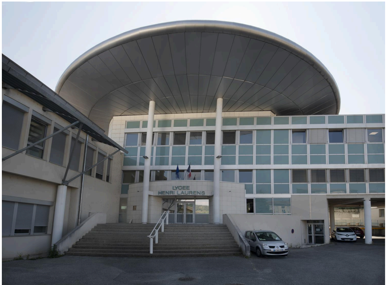
Vue du bâtiment principal
