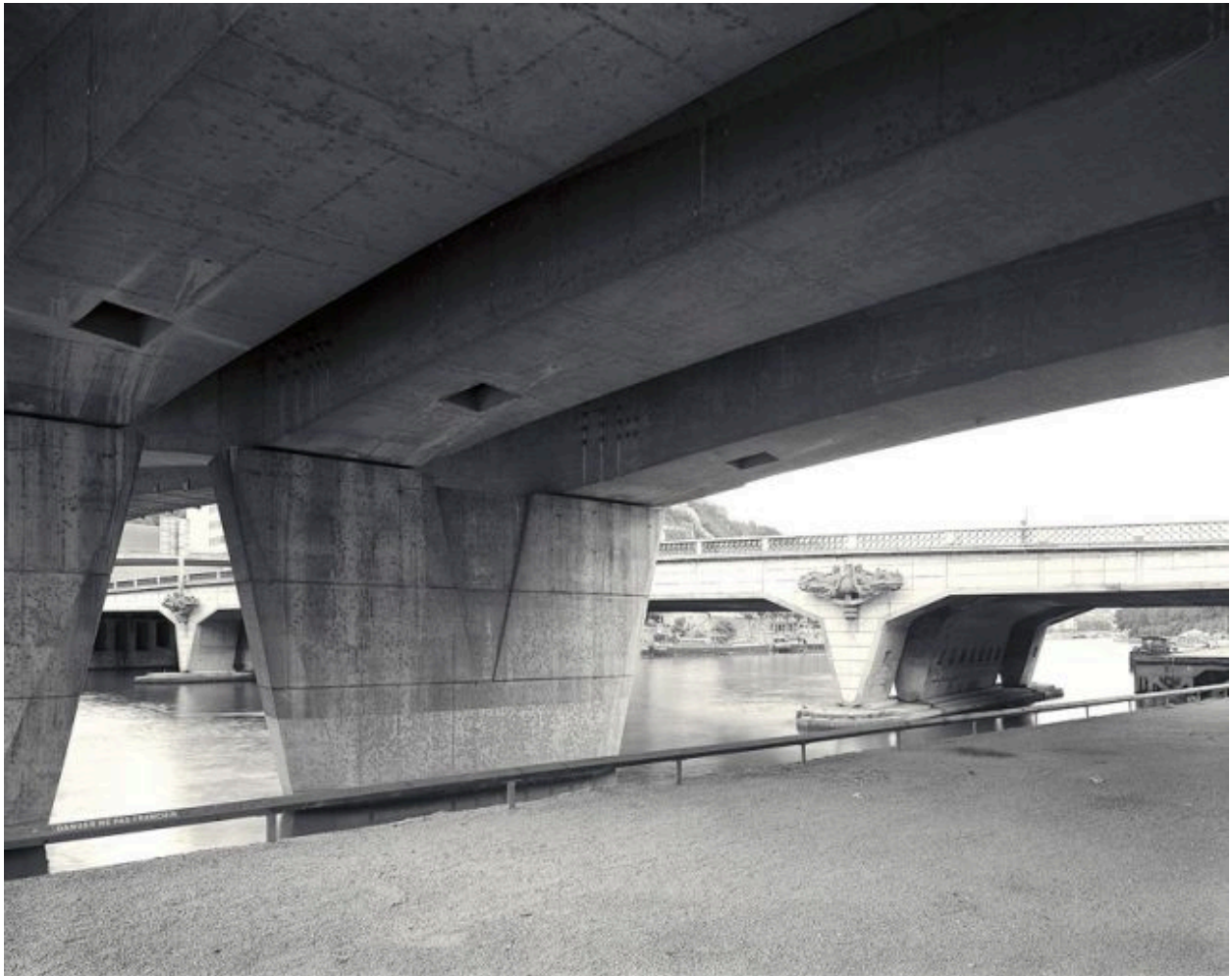
Le pont Kitchener-Marchand depuis le sud
