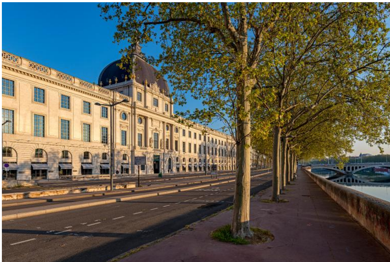
Vue partielle de l'aile Soufflot
