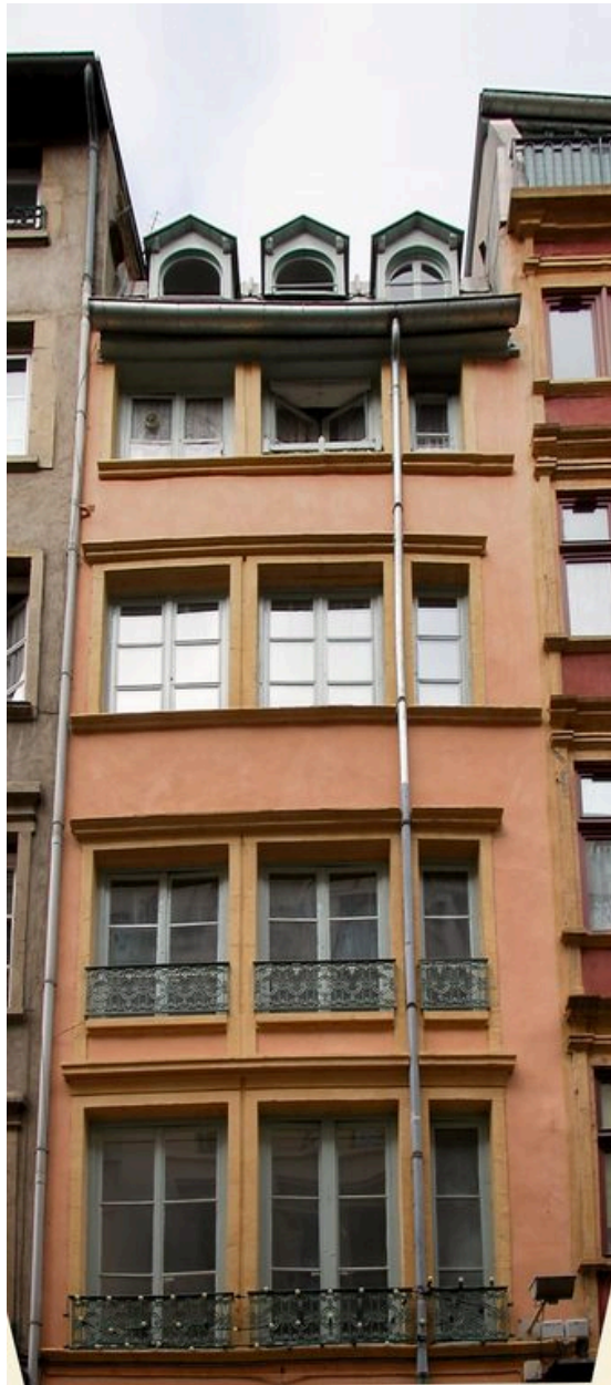
Vue générale des étages carrés rue Mercière
