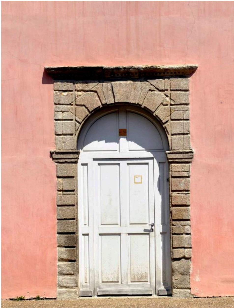
Bâtiment C : porte centrale (ancienne porte de la chapelle des Messieurs)
