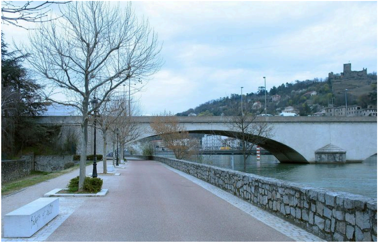
Vue partielle : travée de rive droite, face aval
