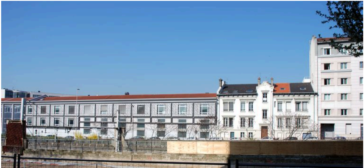
Vue générale de la façade principale de la maison et des bâtiments mitoyens
