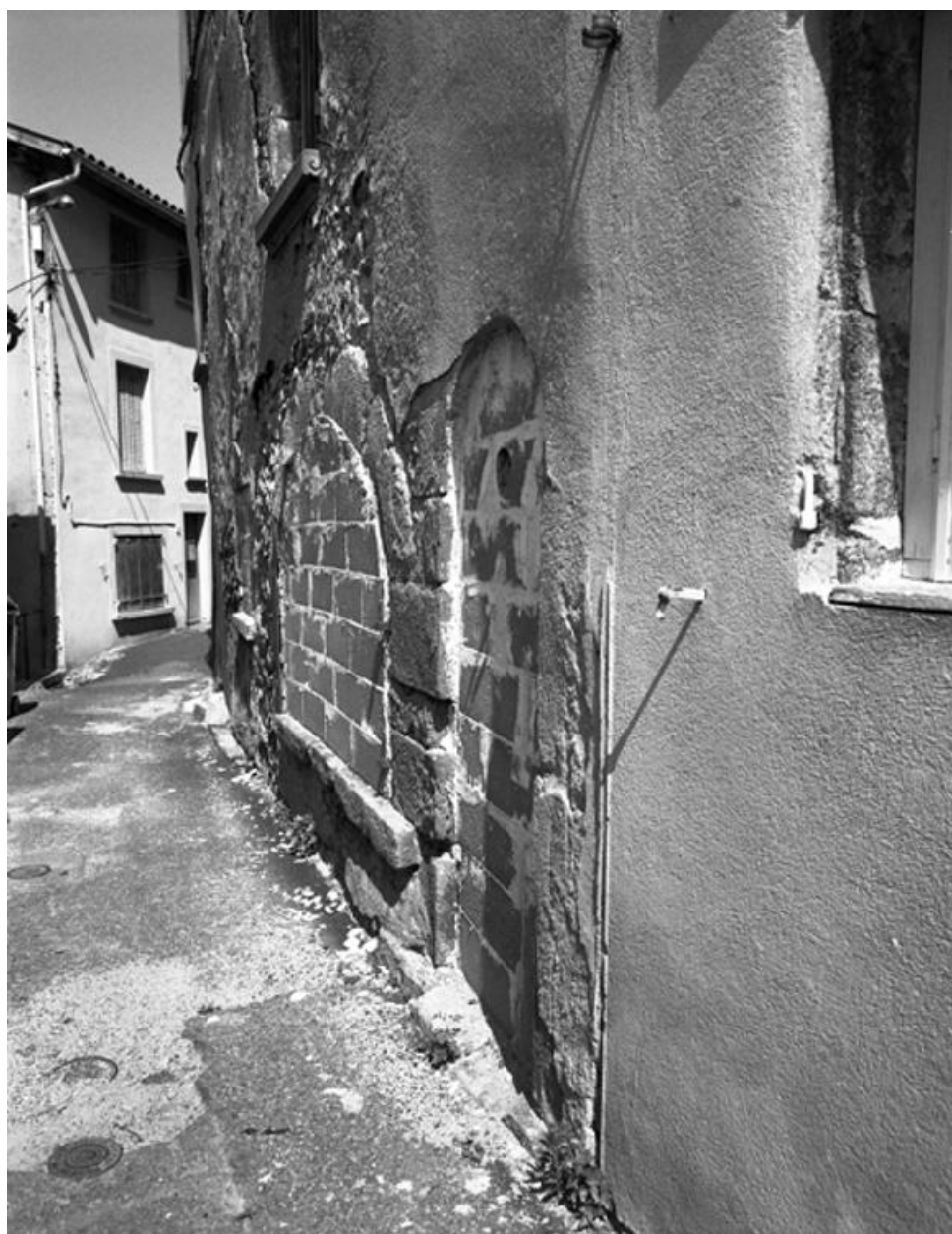
La rue au niveau du n°16, avant travaux.
