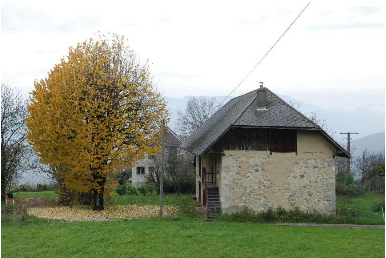
Vue d'ensemble du mur pignon est de la ferme.
