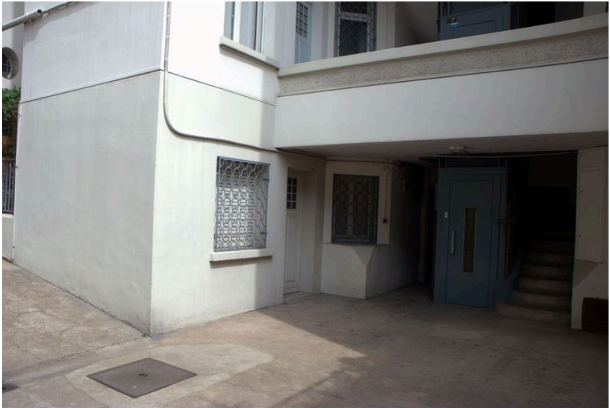
Entrée de service sur cour
