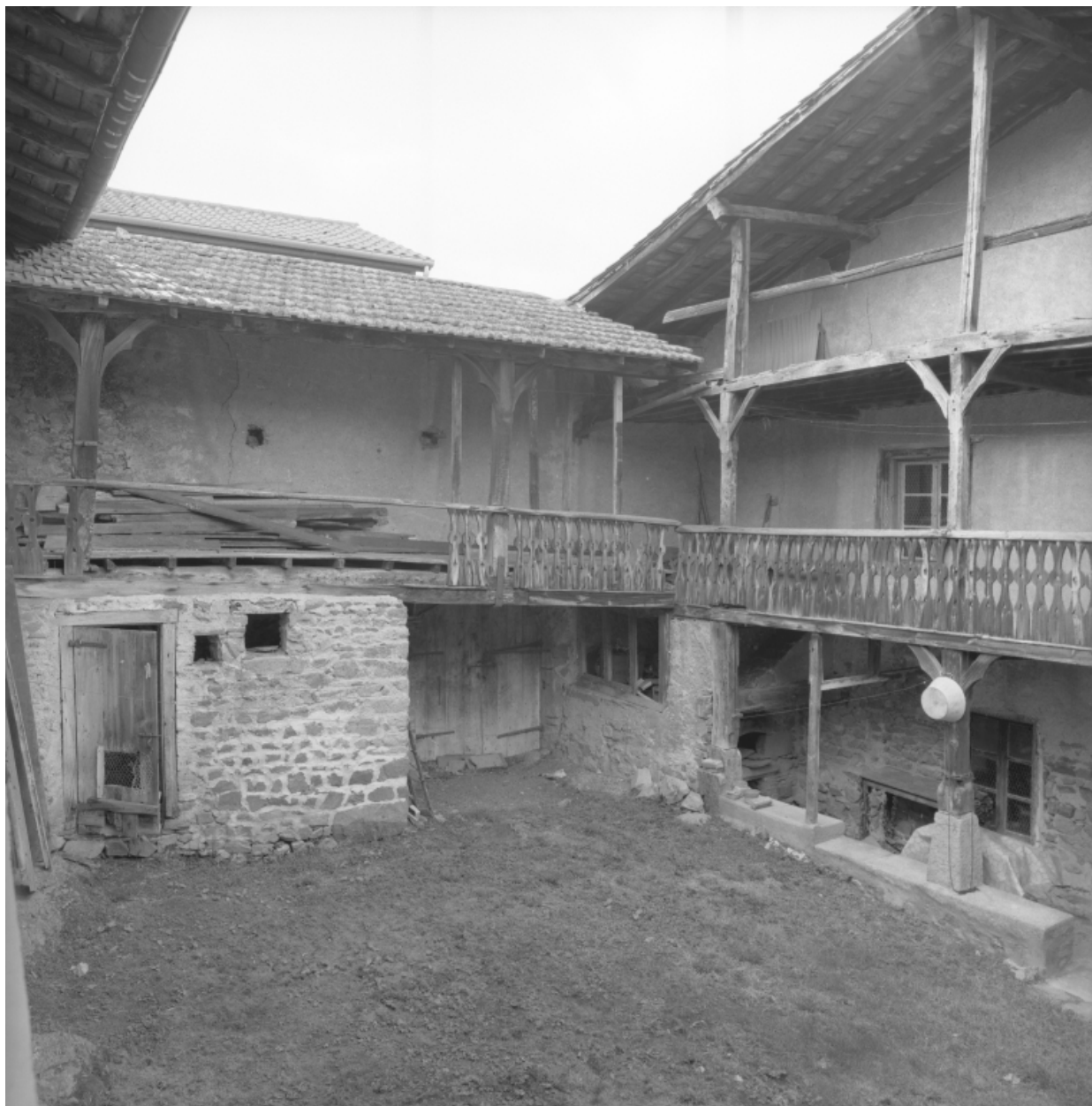
Façade à galerie sur la cour, partie gauche et bâtiment en retour.
