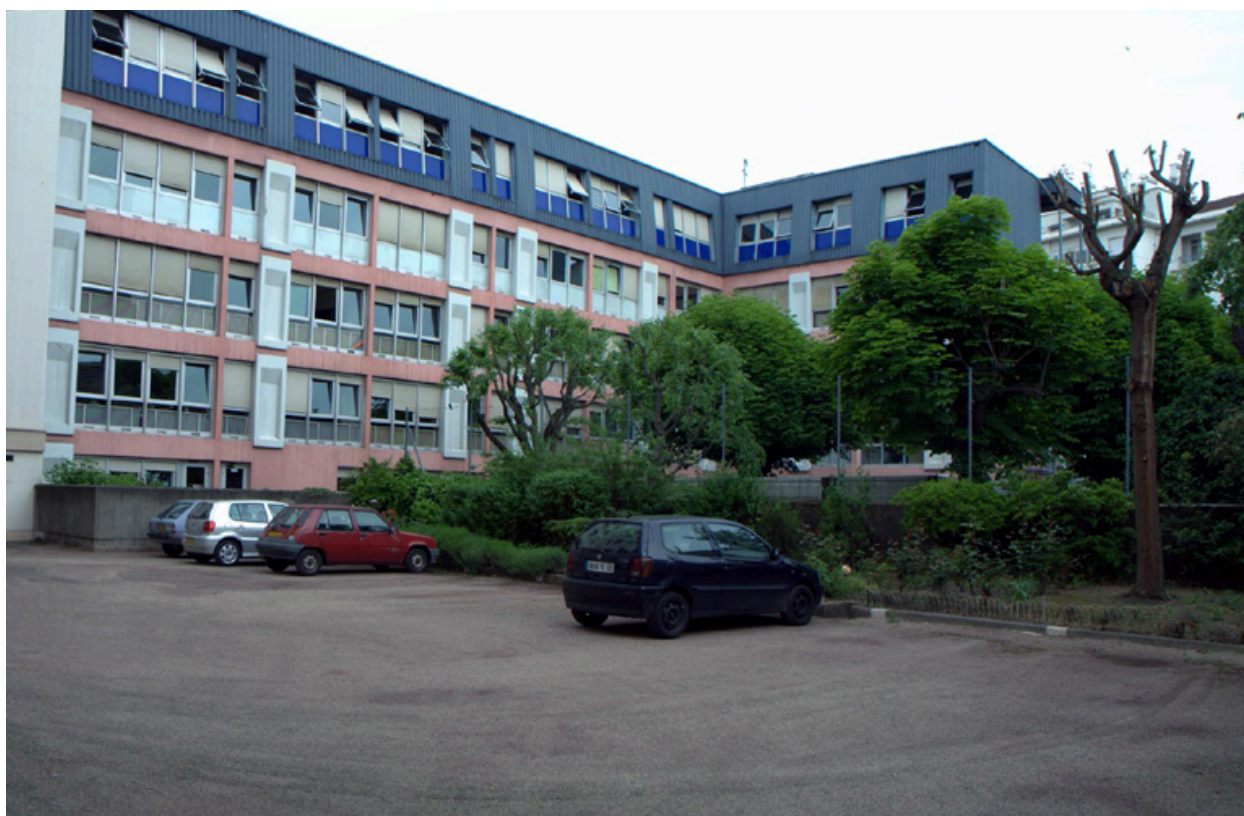
Elévation postérieure, vue d'ensemble
