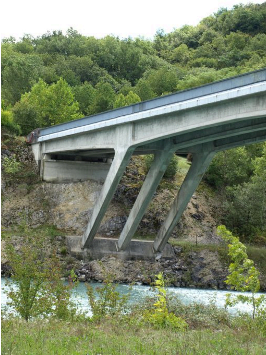
Vue partielle, béquille et culée gauche, face amont (depuis la rive droite)
