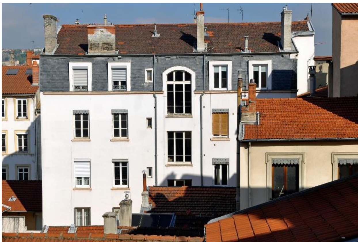
Vue générale, élévation sur cour
