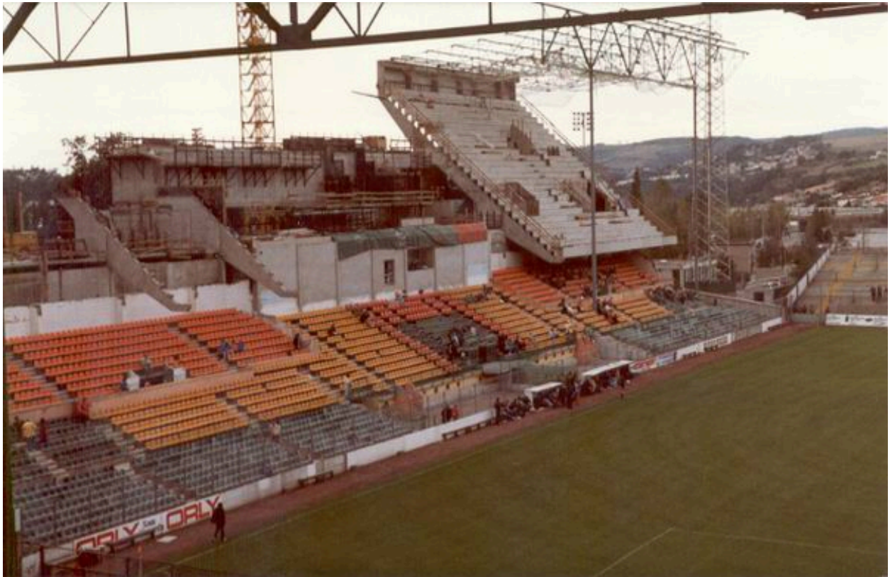
Vue générale. Rénovation du stade
