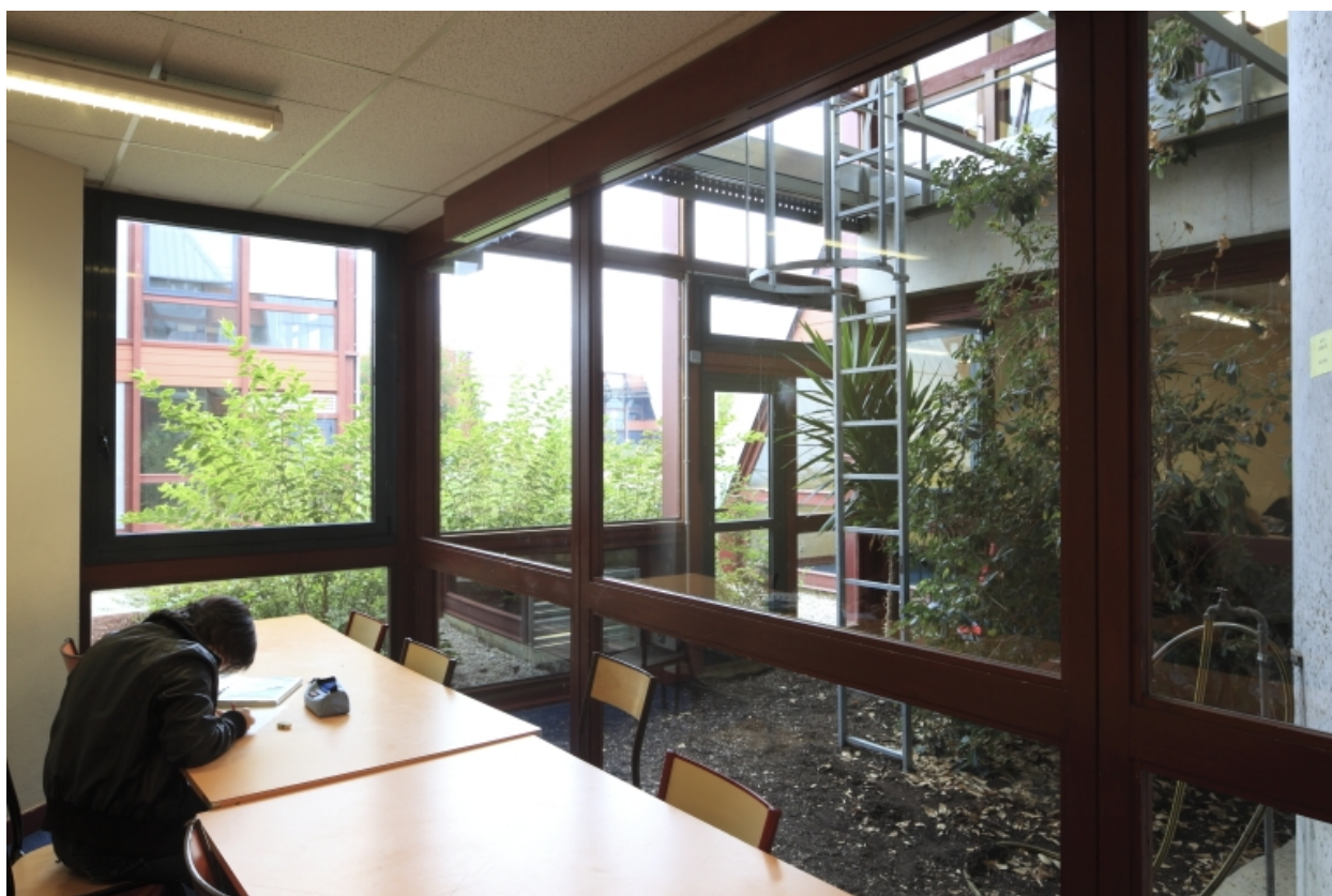
Une salle de classe ouvrant sur une serre thermique.
