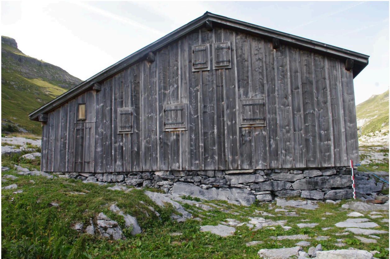
Vue du mur pignon sud
