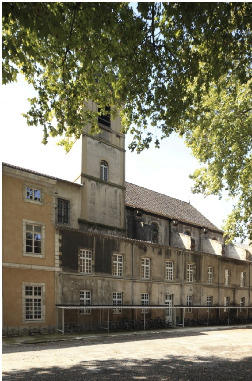
Bâtiment C. Cour sud, façade 17e s. et église.
