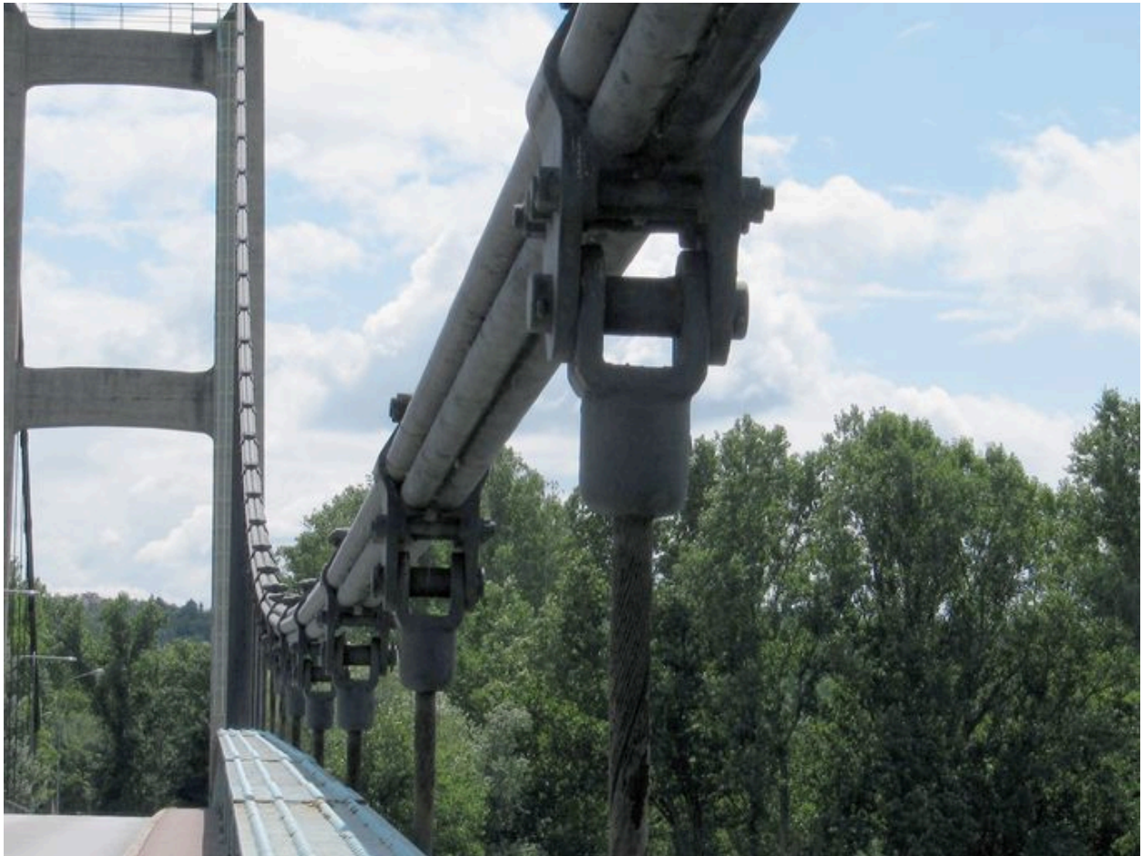
Câble porteur, vue partielle : vers la rive gauche (depuis la chaussée)
