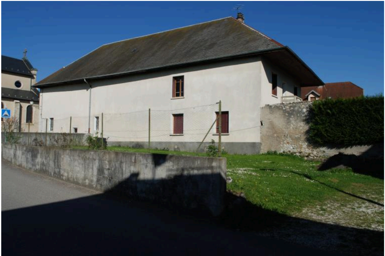
Cusy, B2 103, ferme. Vue d'ensemble de la façade latérale gauche.
