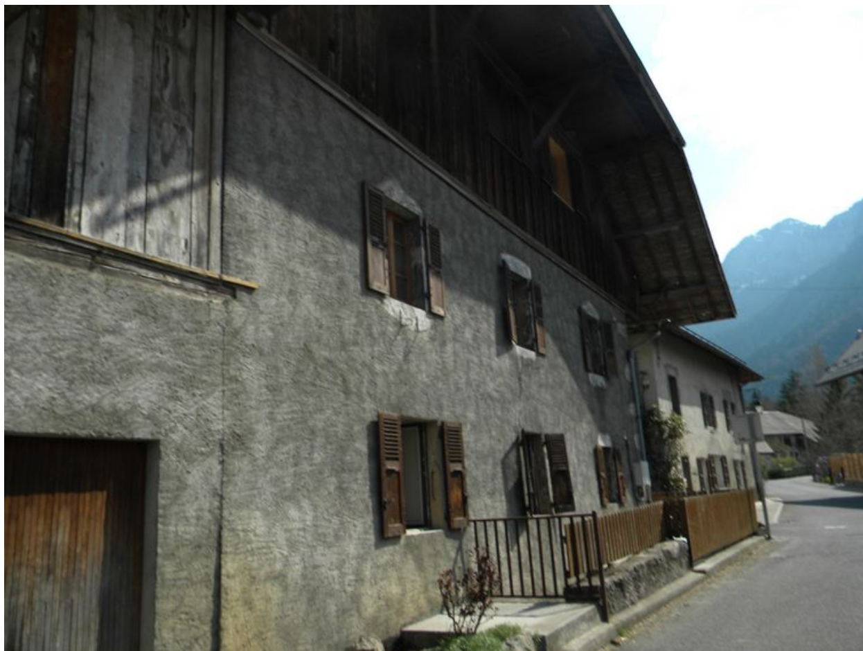
Vue du mur ouest avec accès à la cave.
