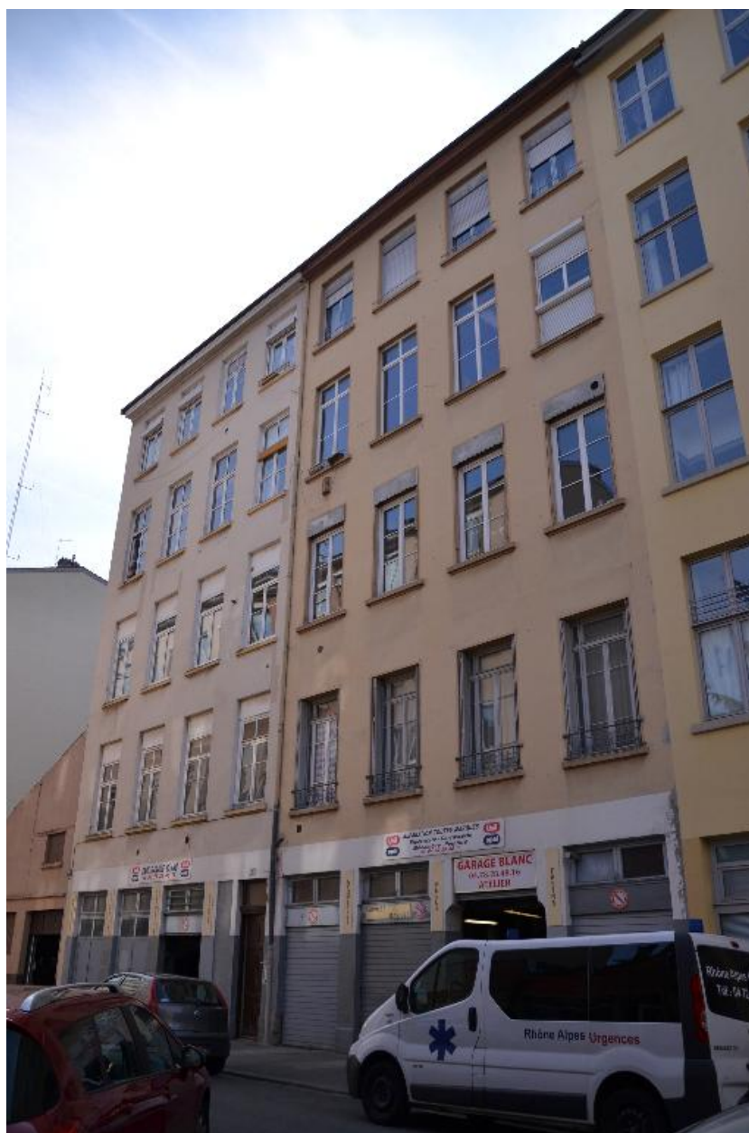
Vue d'ensemble façade nord
