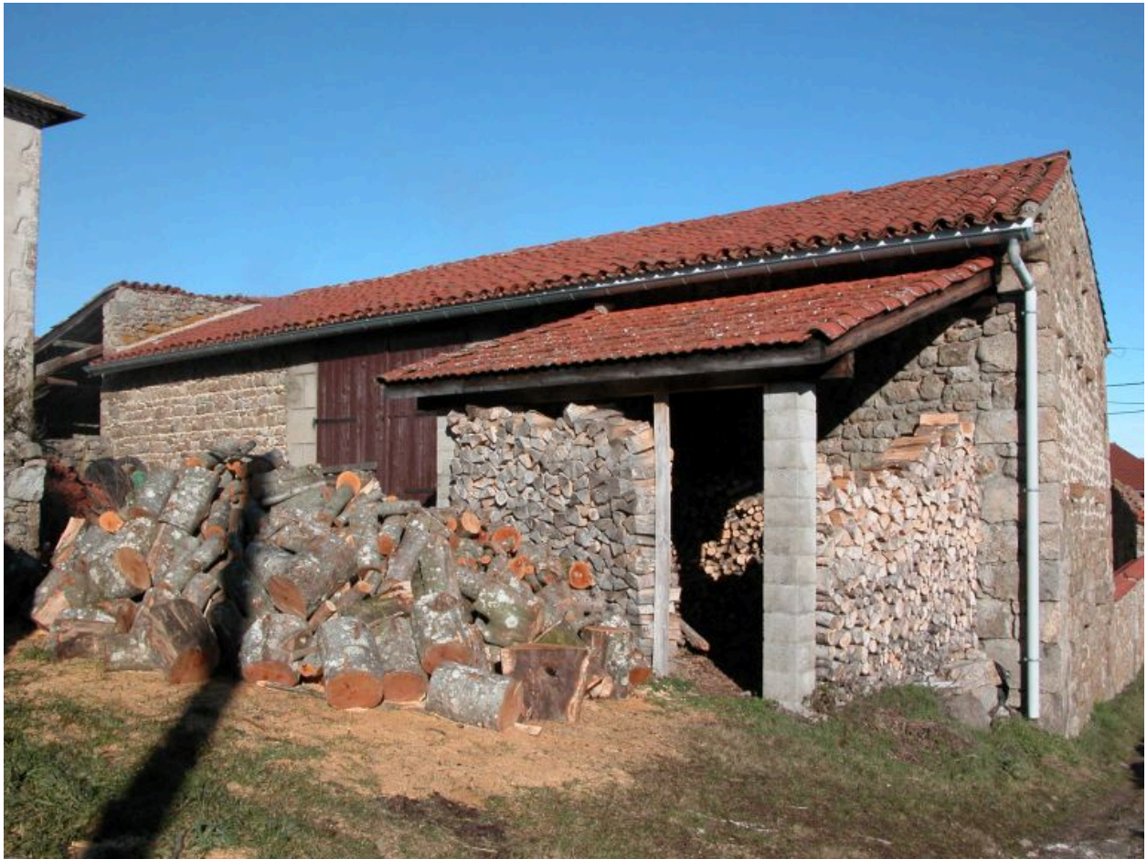
Vue d'ensemble de l'élévation gauche du corps de bâtiment en retour d'équerre.
