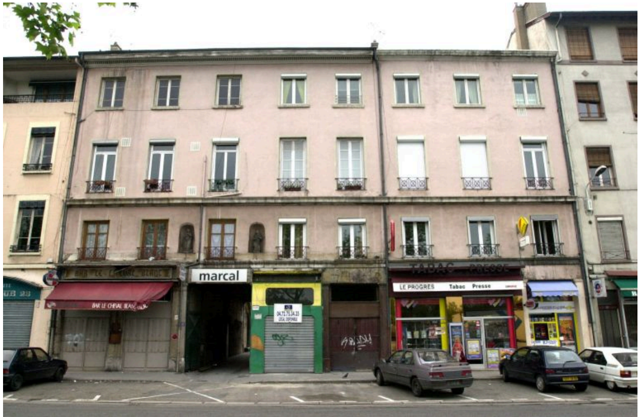
Vue d'ensemble depuis le quai Perrache
