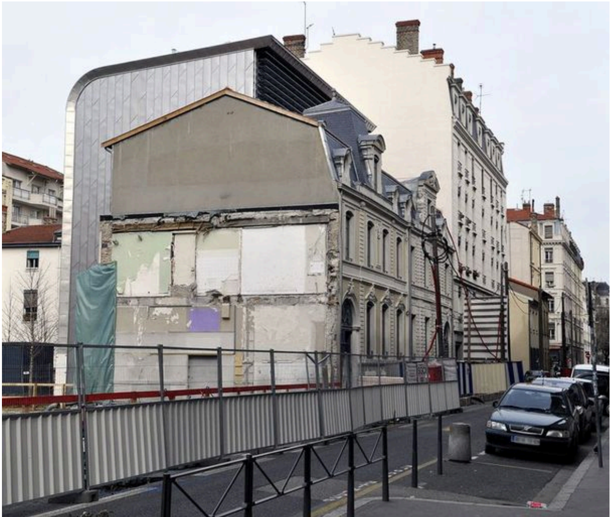
Vue lors des travaux de reconversion
