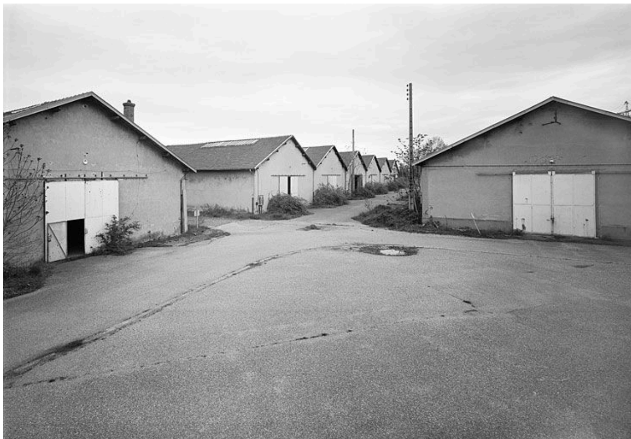
Vue d'angle des entrepôts
