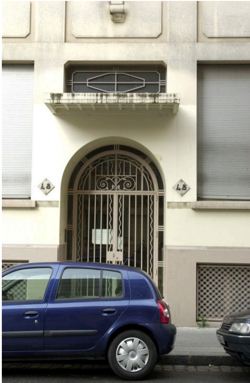
Détail de la porte principale
