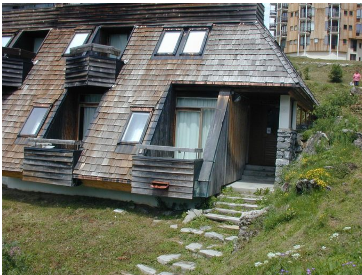
Le Mélèze 2. Entrée amont sur la montée des Mélèzes
