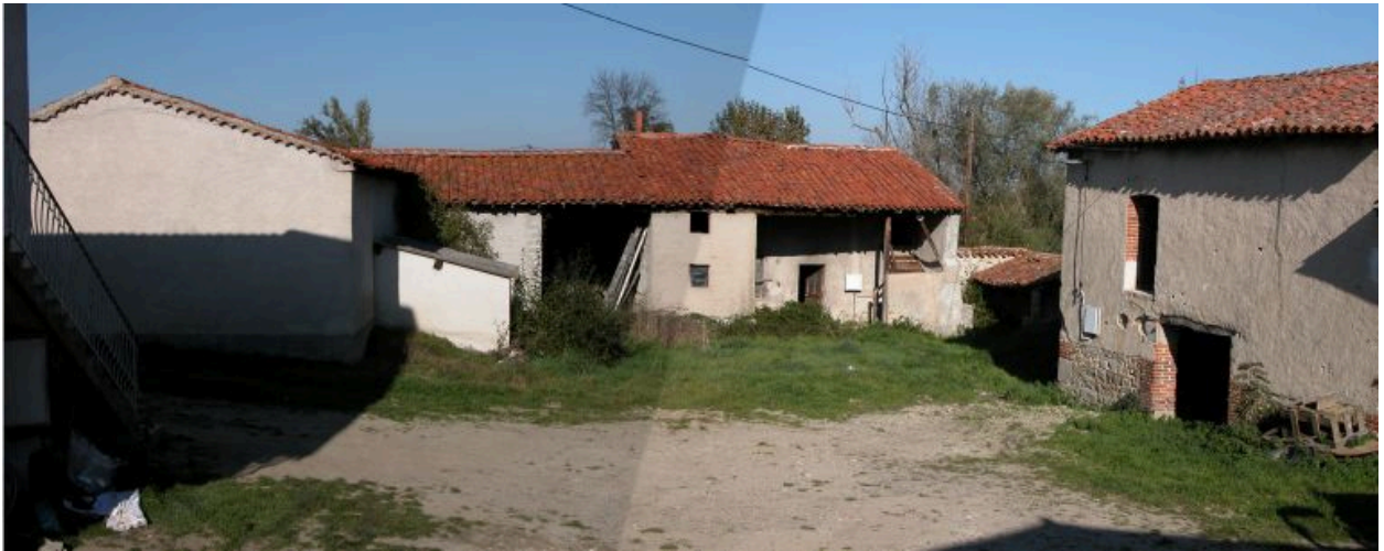
Vue générale de la ferme depuis l'intérieur de la cour.
