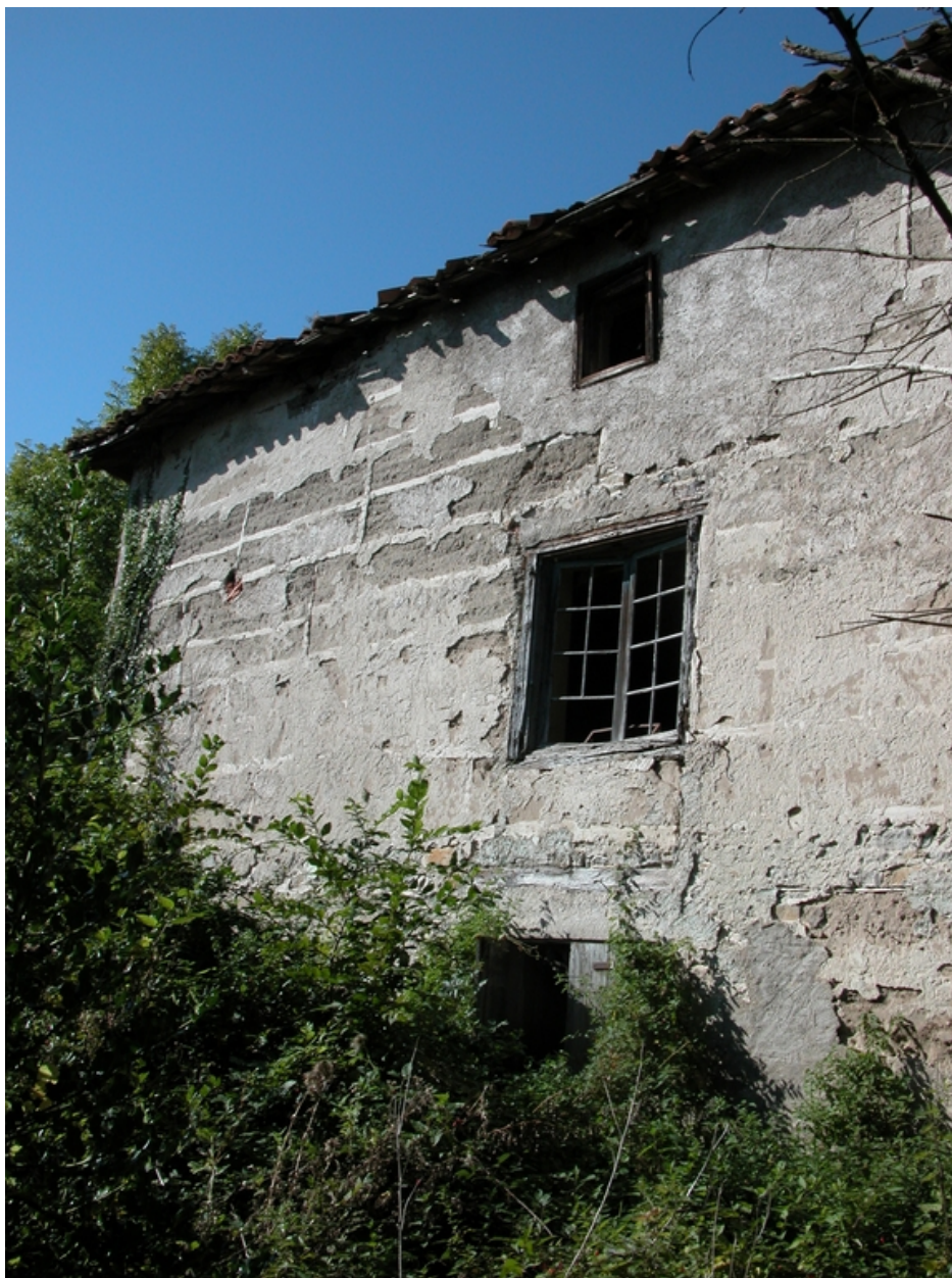
Vue de la façade sur cour, partie sud.
