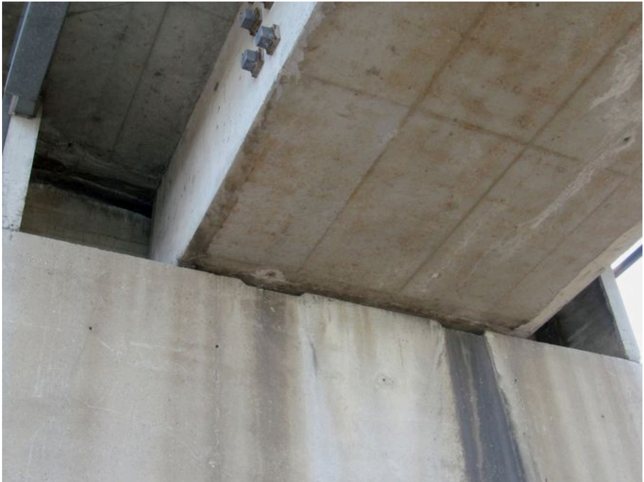
Tablier, vue partielle de dessous au niveau de la culée de la rive gauche
