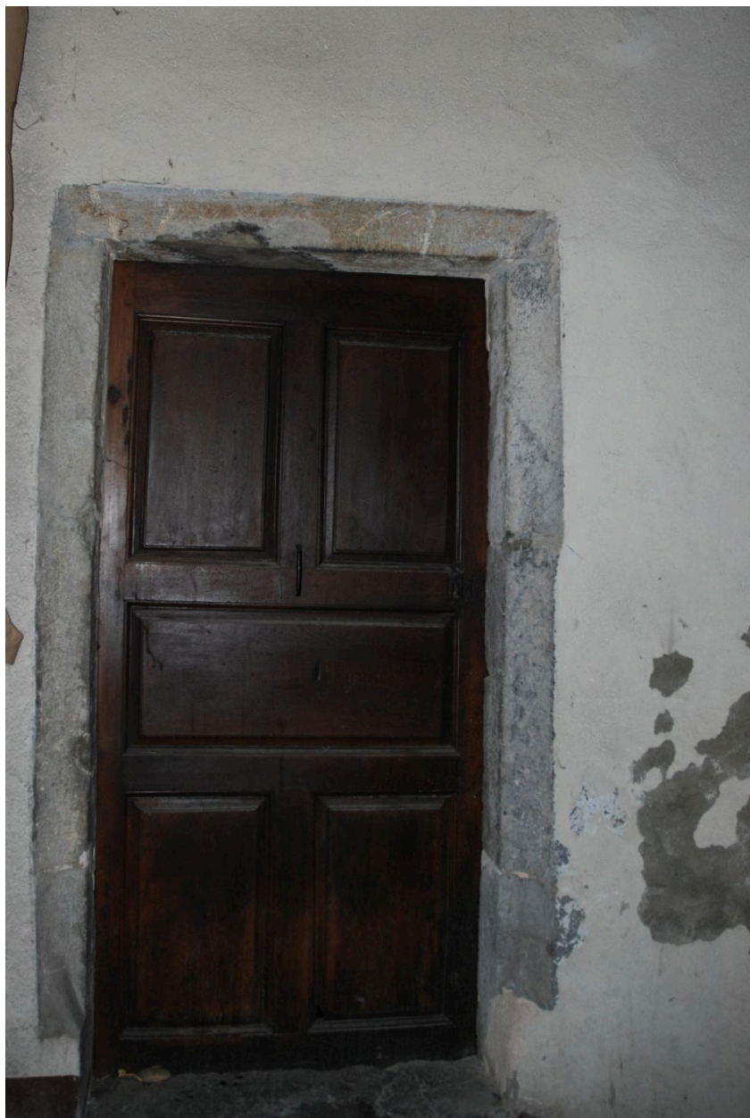
Maison, immeuble, 48 à 58 rue Louis Blanc-Pinget (2018 E1 350). Bâtiment sur cour. Logements : palier du 1er étage, porte à encadrement en pierre de taille.
