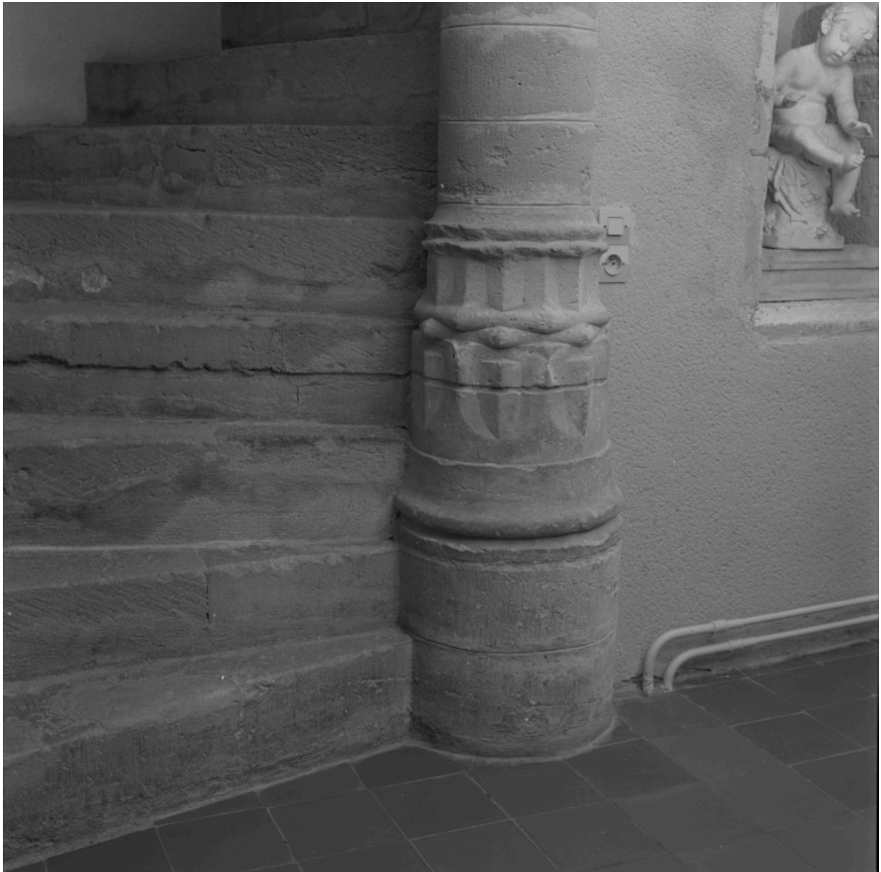
Départ de l'escalier, détail de la base du noyau.
