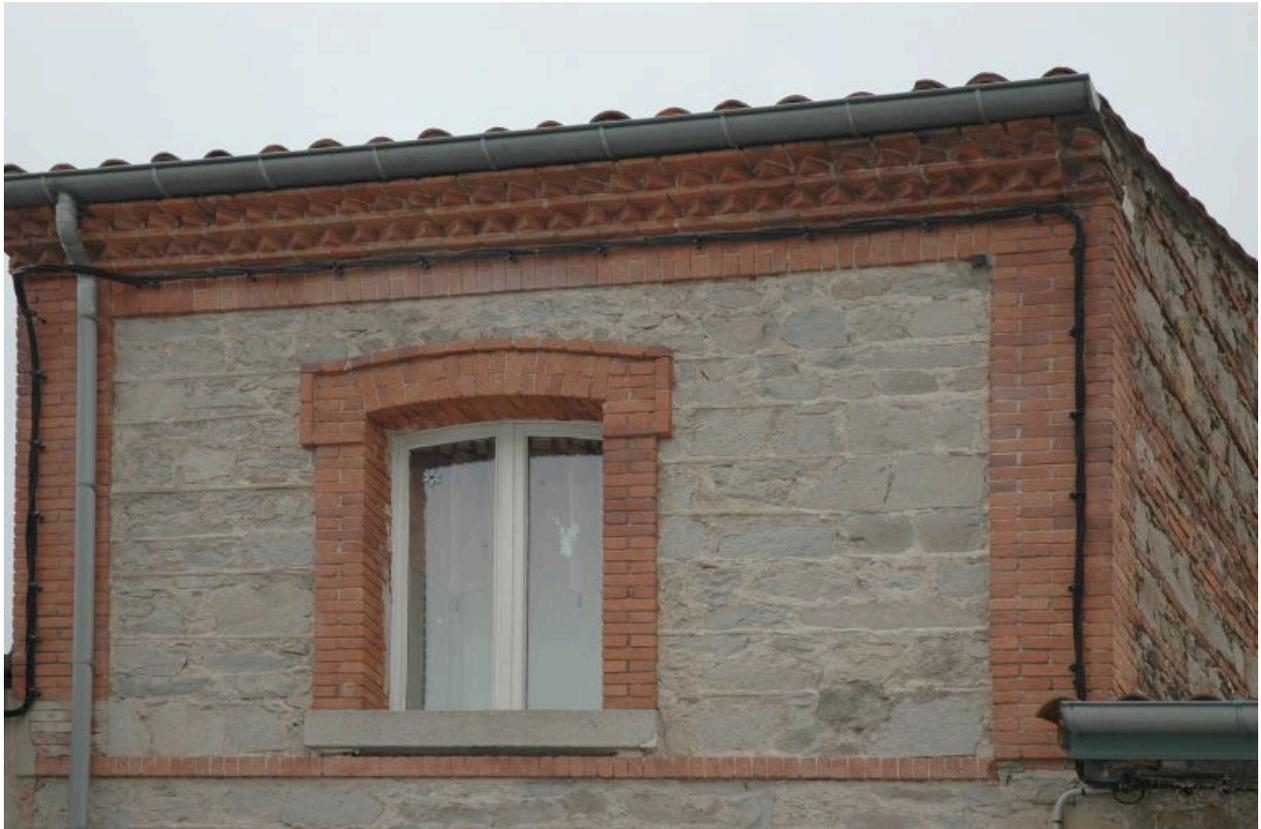
Utilisation de la brique dans les encadrements de fenêtres et la corniche à denticules.
