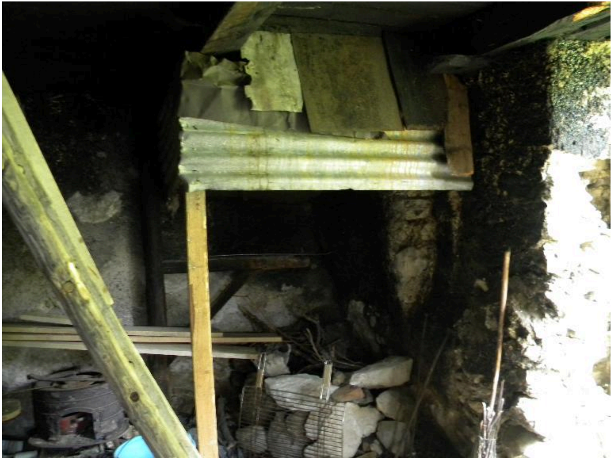
Vue du foyer avec l'ancienne potence.
