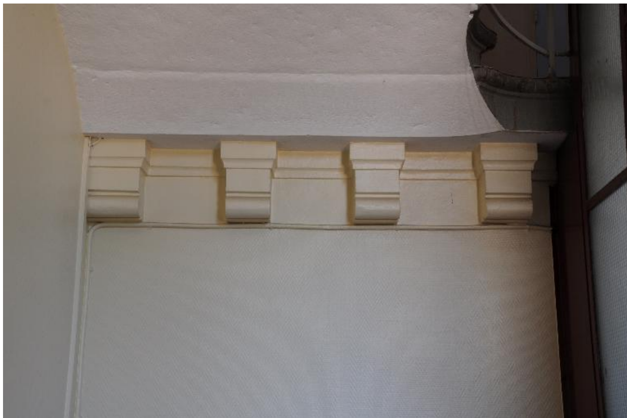
Cage de l'escalier, modillons
