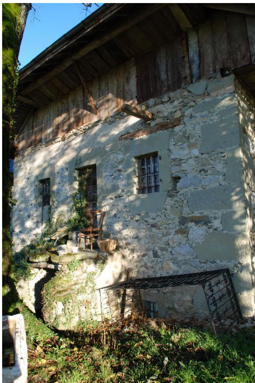
Vue partielle de la façade de la cave-grenier (?)
