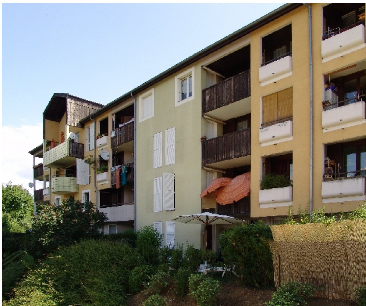
Façade occidentale d'un immeuble vue de trois-quart droit
