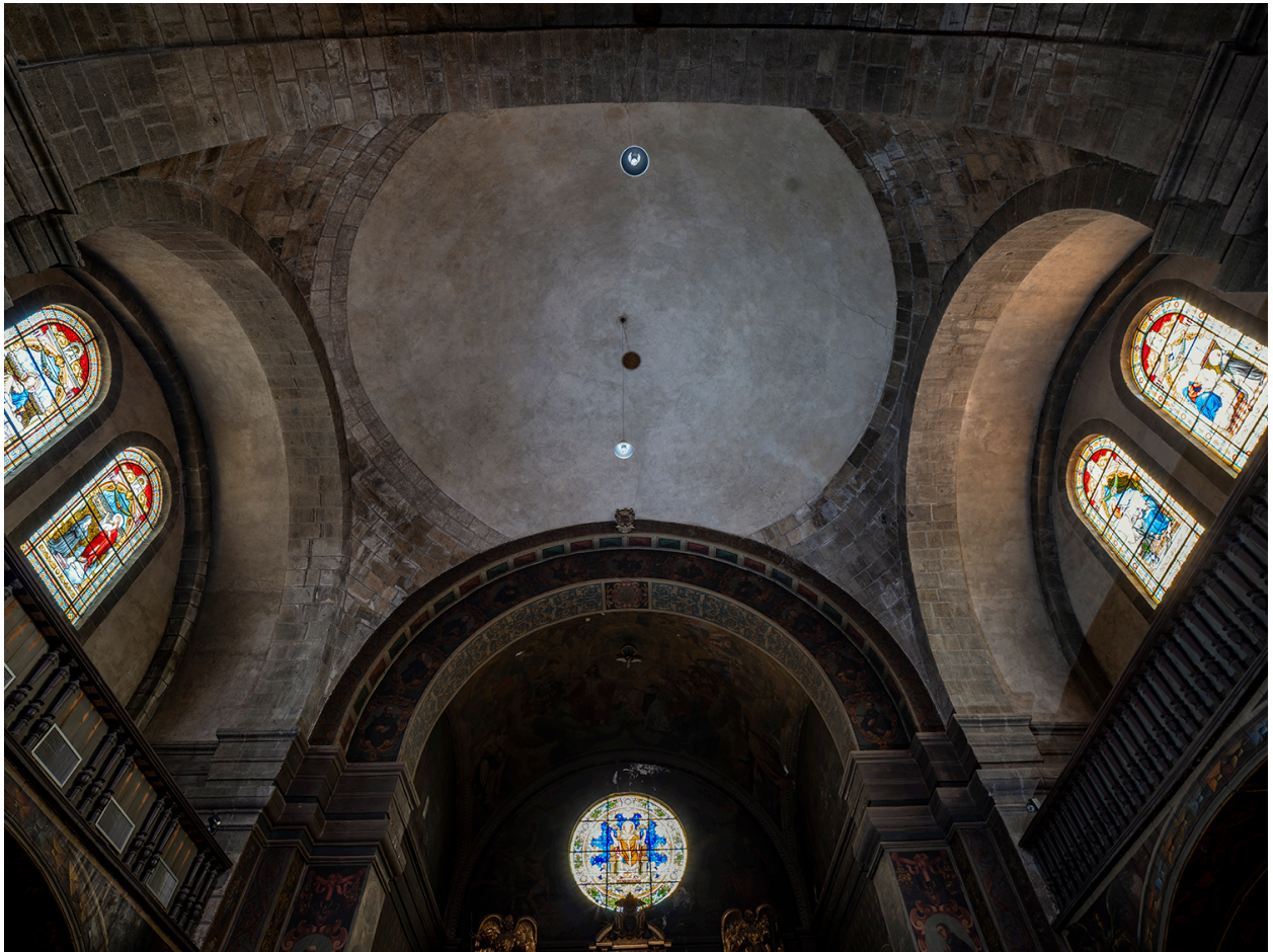
Vue de la coupole à la croisée du transept
