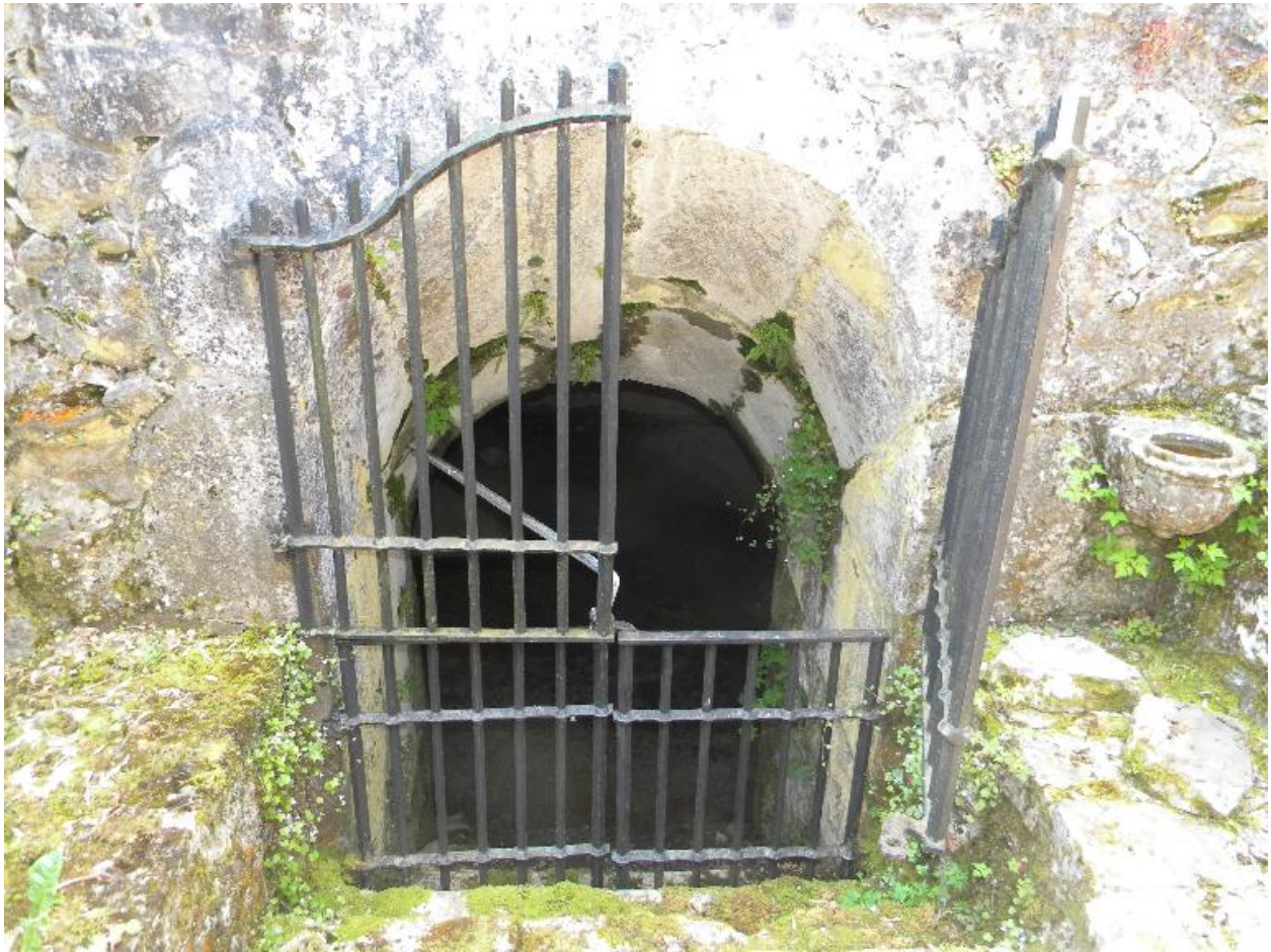
Vue de l'entrée nord de la cave.
