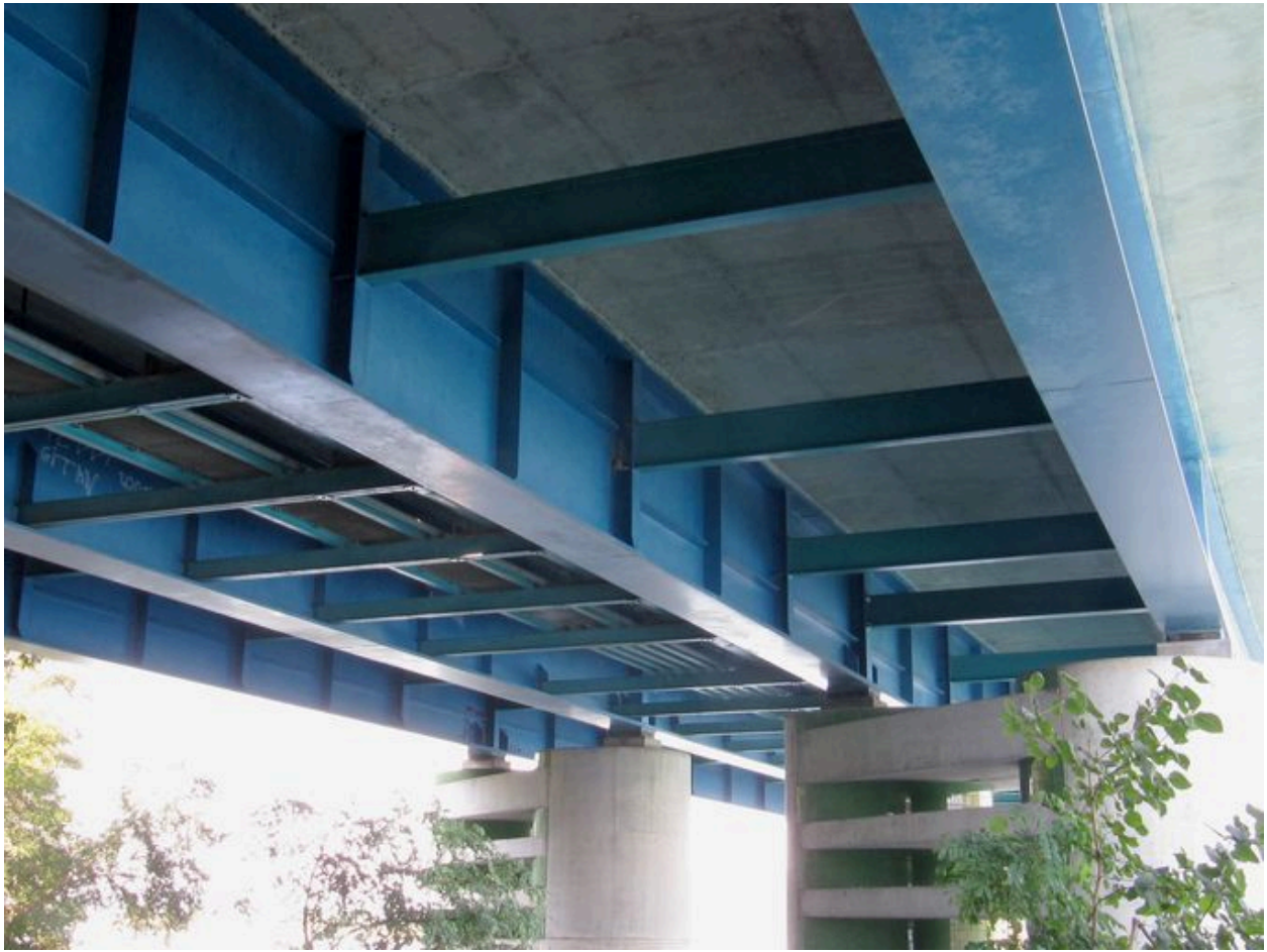
Vue partielle, de dessous, tablier (depuis la rive gauche)
