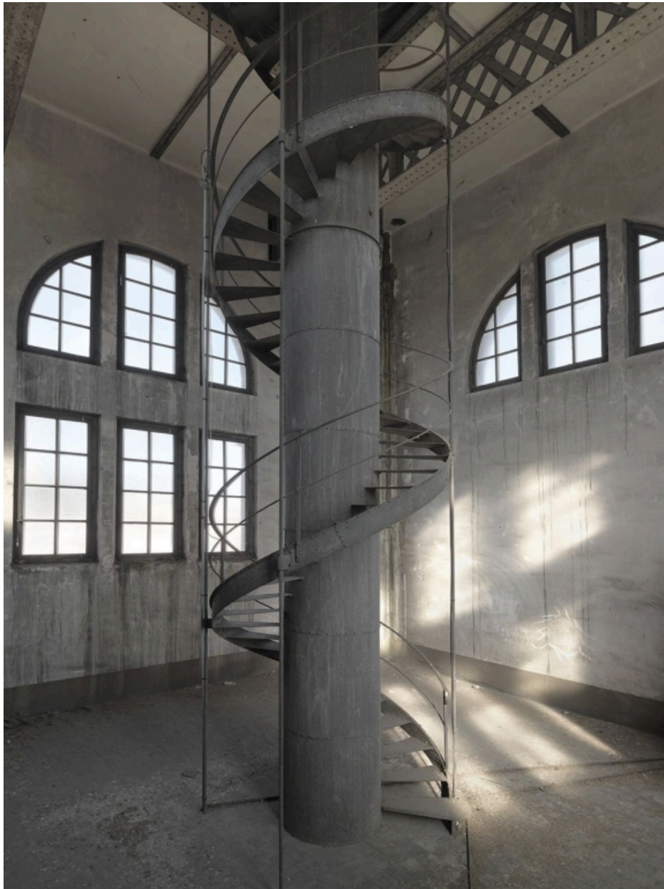
Le dôme Pascalon. Escalier d'accès au lanternon depuis le sud-est
