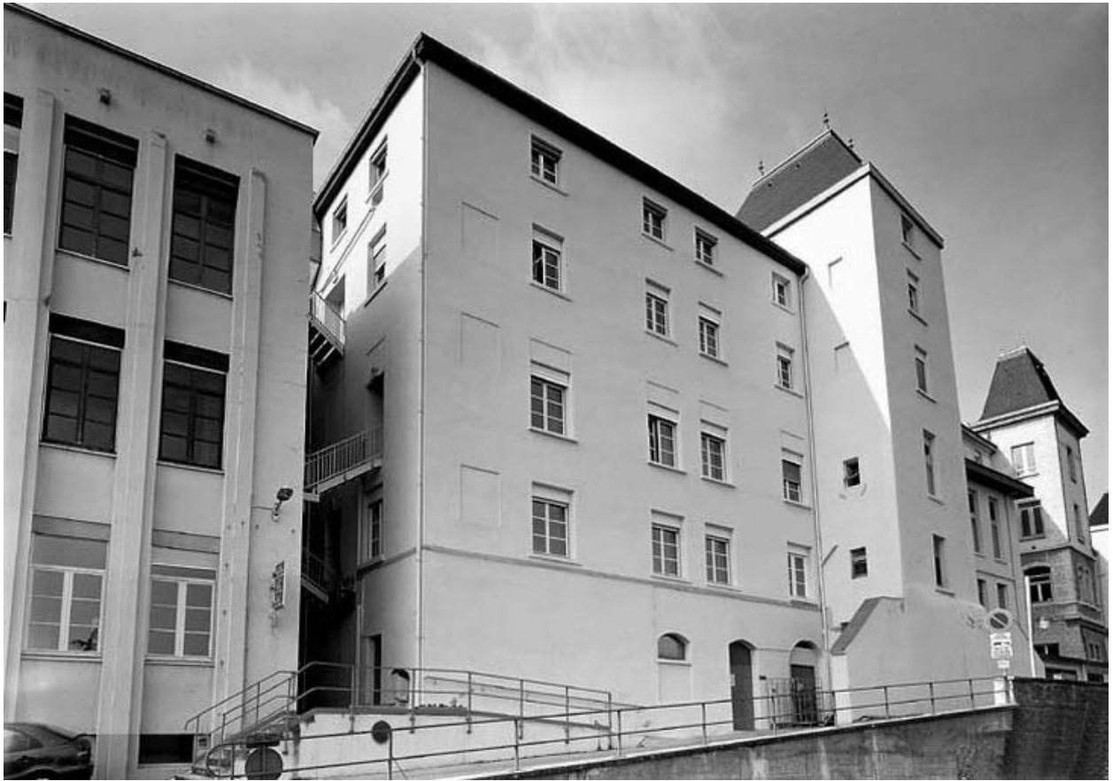
Grande façade est, élévation du bâtiment 8 et pavillon sud
