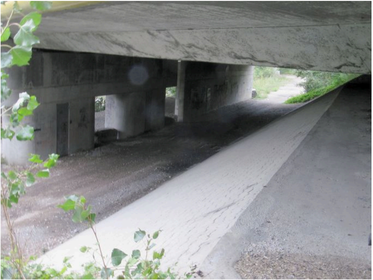
Travée passante et culée droite, face amont, vue partielle (depuis la rive droite)
