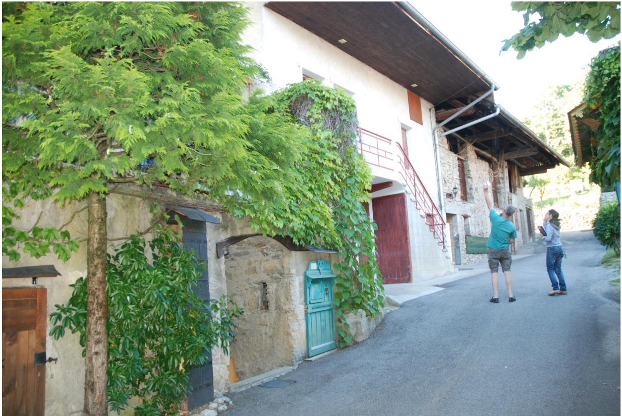
Fermes à juxtaposition (2018 I1 51 à 55), vue d'ensemble depuis le sud.
