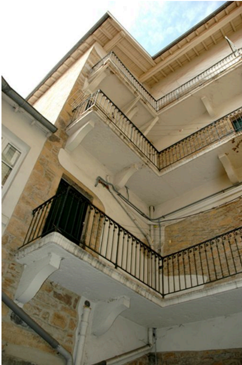
Coursières contre la façade sud sur cour
