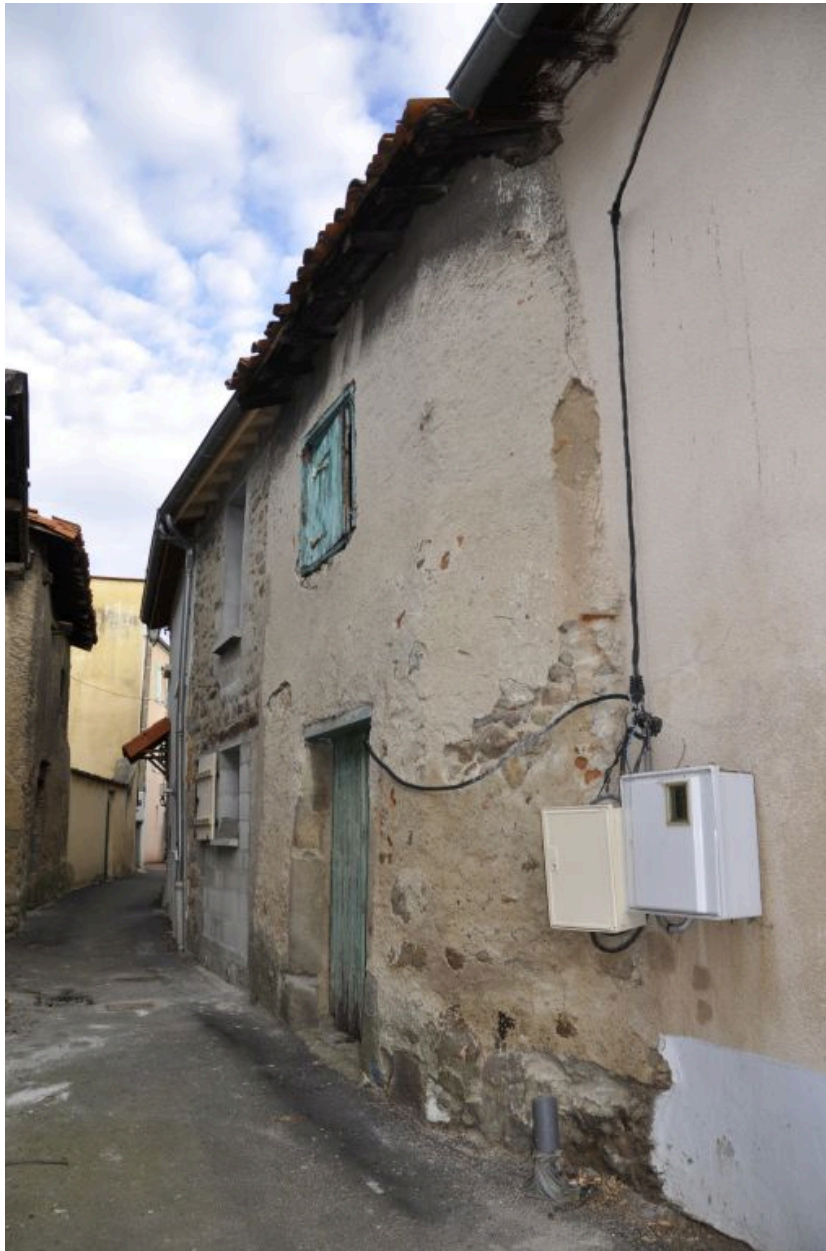
1986 AE 148, 149, rue de la Vieille Cité. Cuvage, maison, vue d'ensemble.
